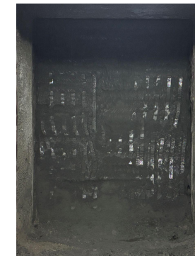
切羽状況写真
