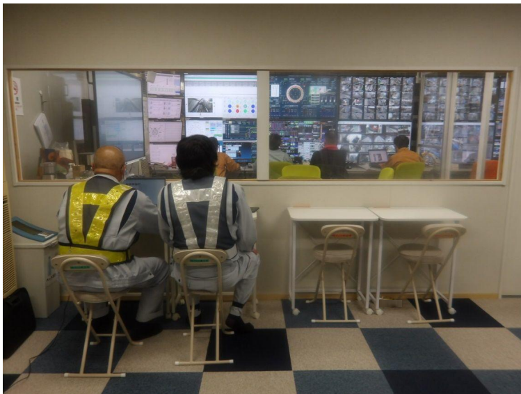
掘進管理状況日常点検
