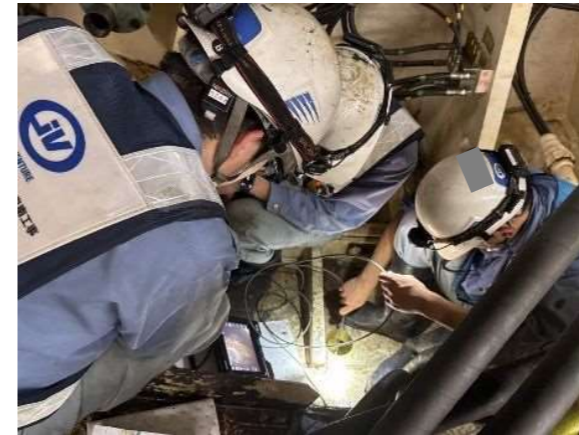
ファイバースコープによる点検状況
