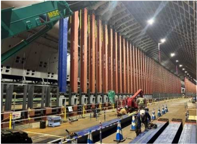
地中拡幅部坑内
