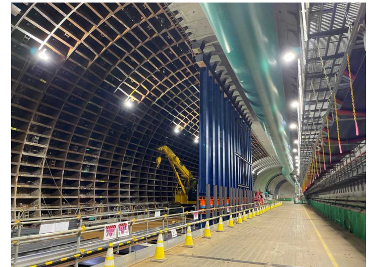
地中拡幅部坑内
