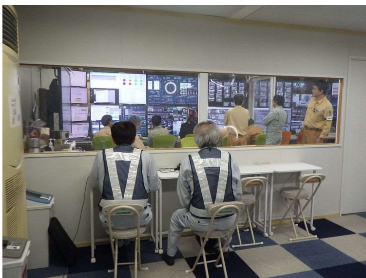
掘進管理状況日常点検
