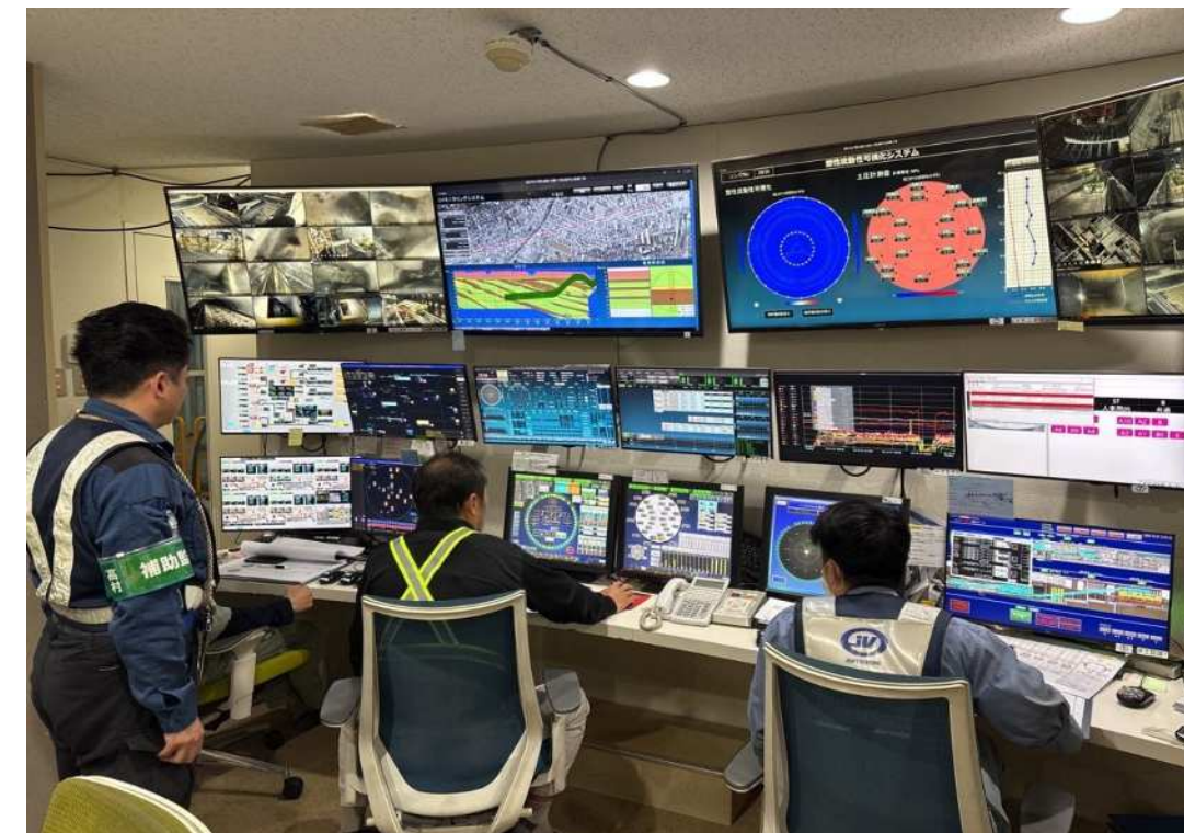
掘進管理状況日常点検
