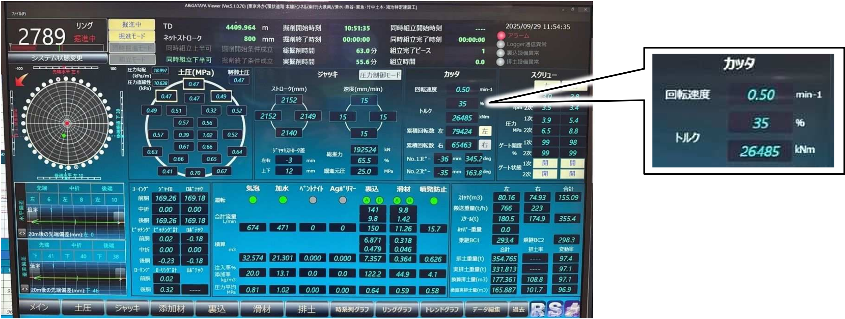
カッタートルクのリアルタイム監視状況 (2789R)
