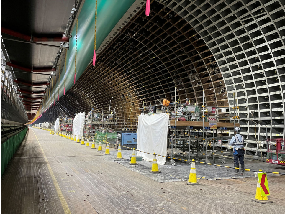
地中拡幅部坑内
