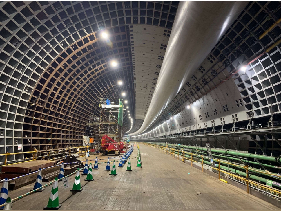
地中拡幅部坑内
