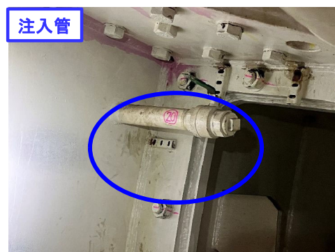
滑剤充填設備(中央JCT南側Fランプシールドトンネル工事の実績)
