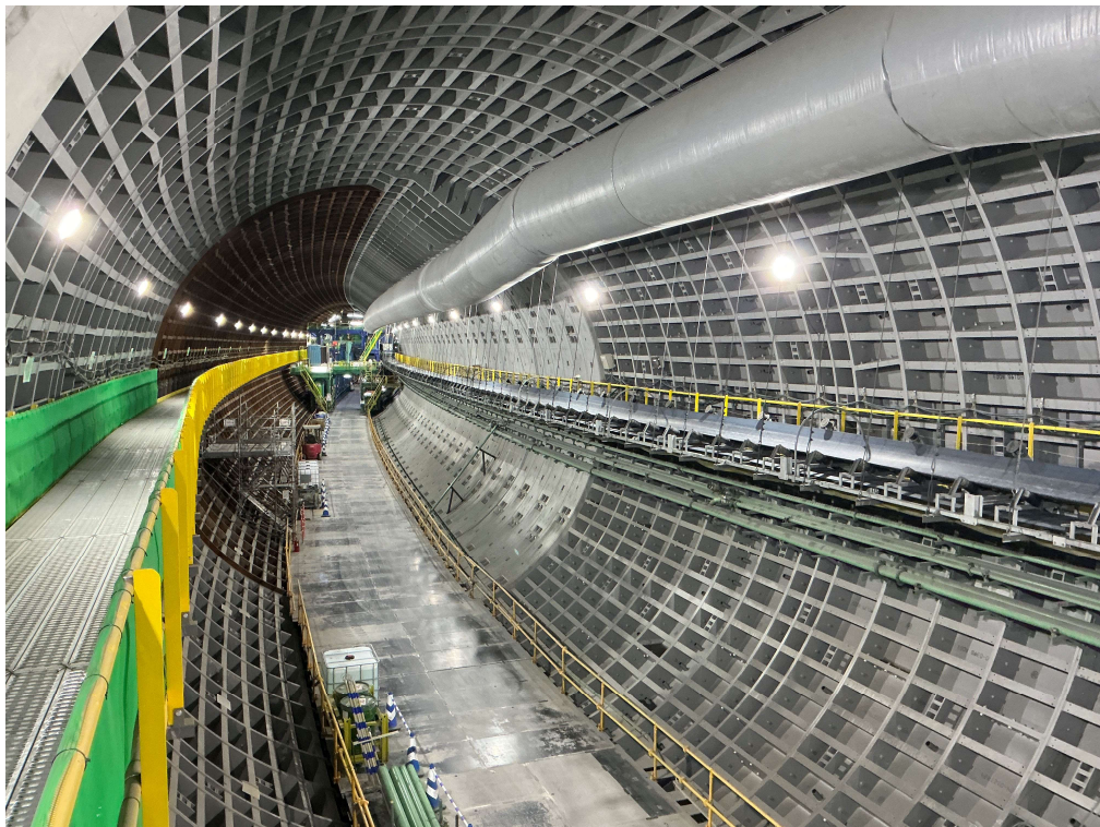
トンネル坑内
