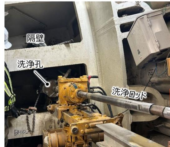
写真\_高圧洗浄の作業状況
