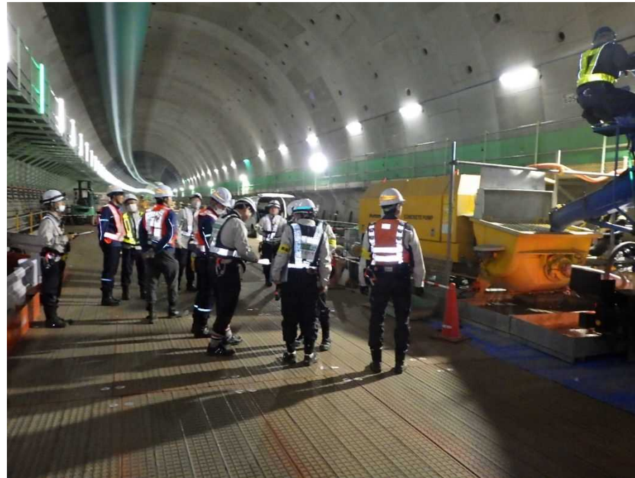
受発注者合同のパトロール（令和6年1月23日）
