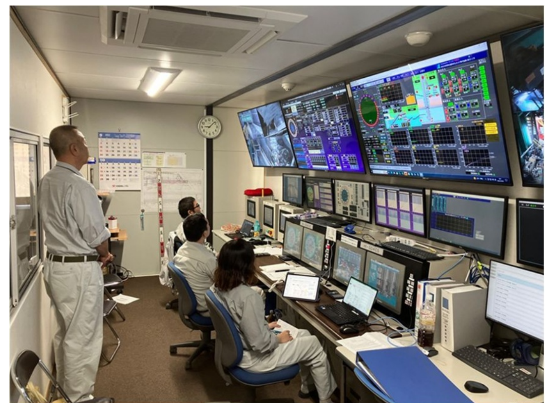
掘進管理状況日常点検
