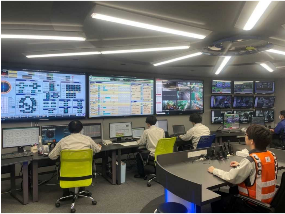
掘進管理状況
