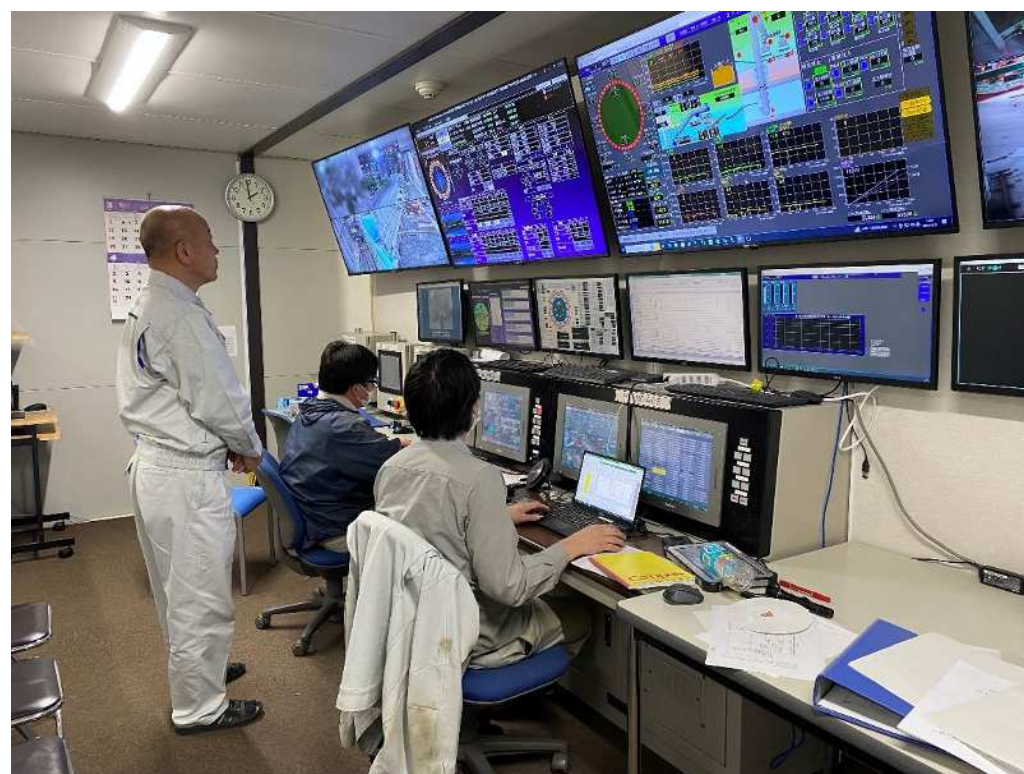
掘進管理状況日常点検＜掘削作業中＞
