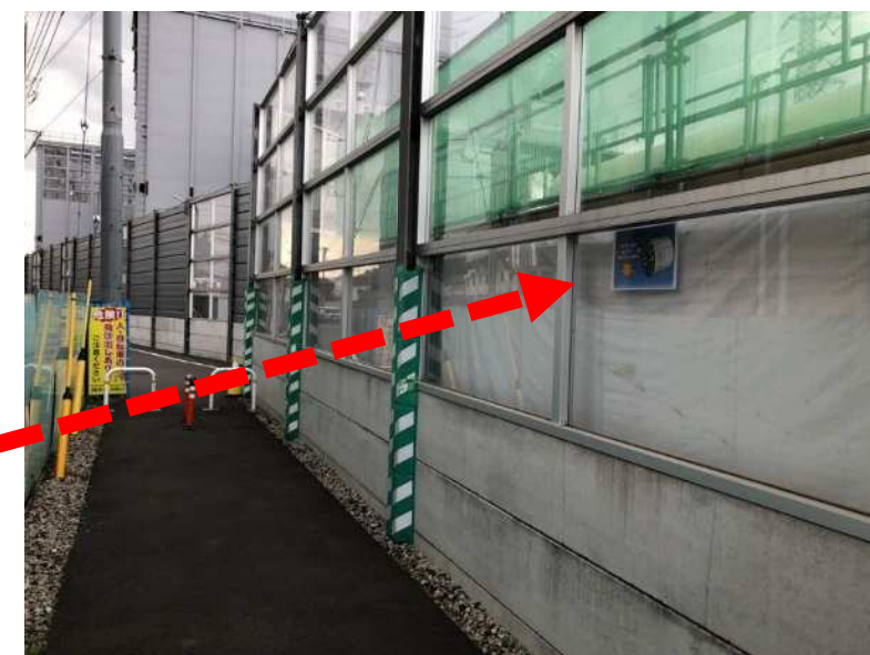
【シールドマシン掘進位置の目の印表示】
