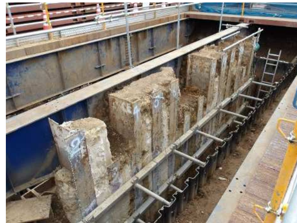
地中壁露出確認状況
