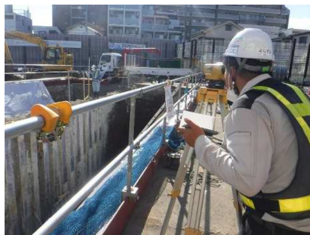
現地測量確認状況
