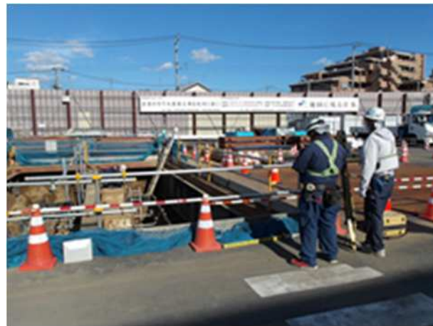
現地測量確認状況
