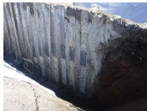
地中壁露出確認状況
