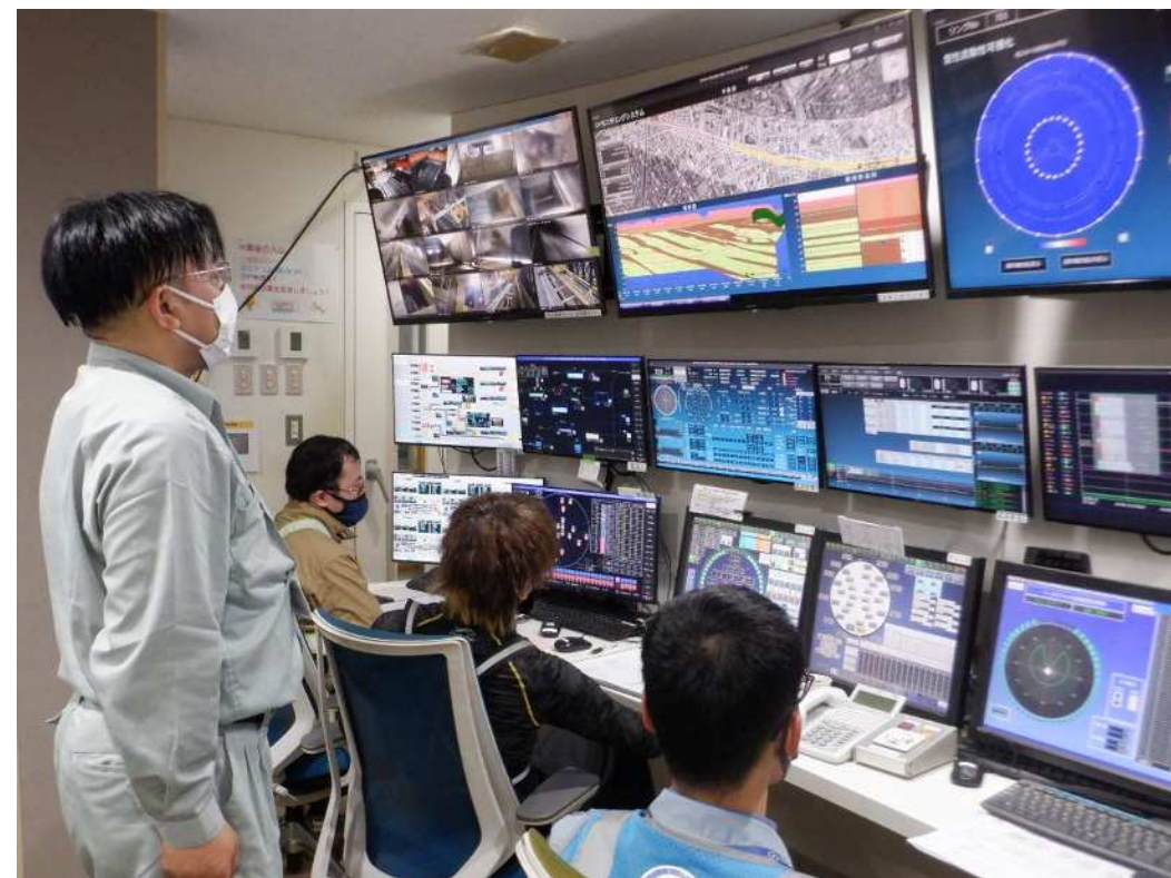
掘進管理状況日常点検
