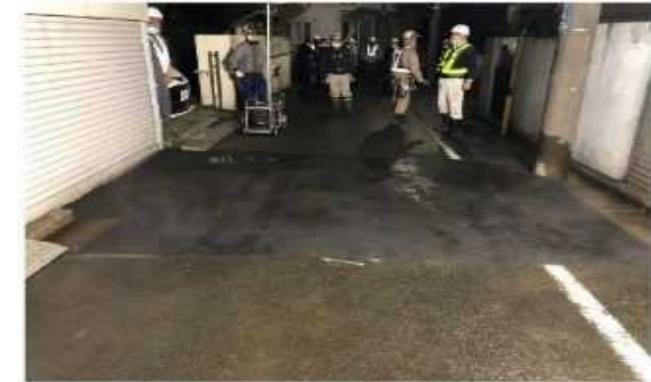
陥没箇所の応急復旧対応状況(舗装完了)
