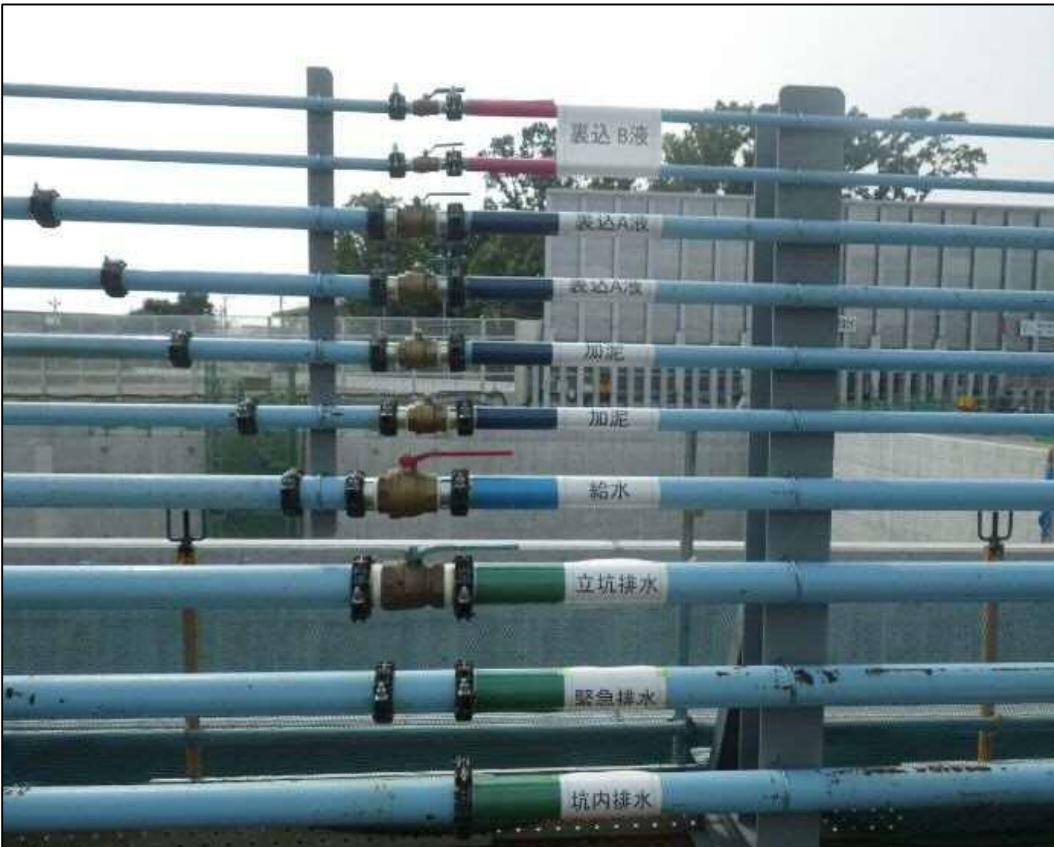
気泡添加材のプラント（製造）箇所は後続台車であり、後続台車から配管パイプを通してマシンへ注入する。
