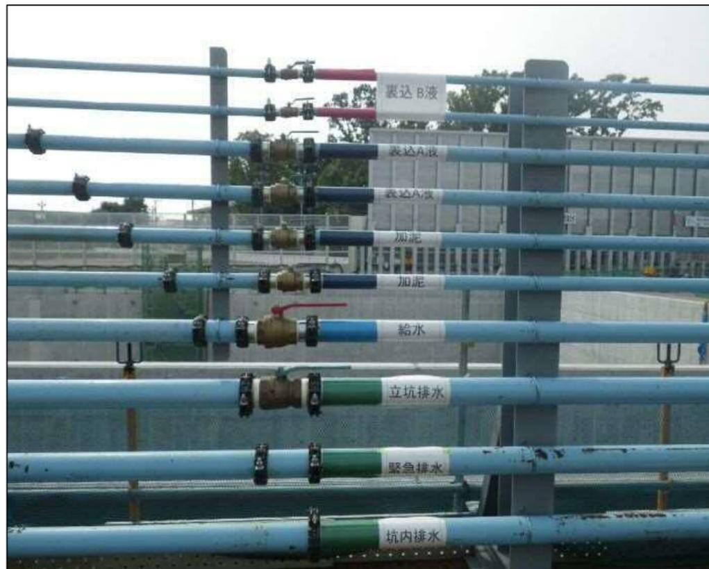
気泡添加材のプラント（製造）箇所は後続台車であり、後続台車から配管パイプを通してマシンへ注入する。（後続台車は現在、投入、組立中）
