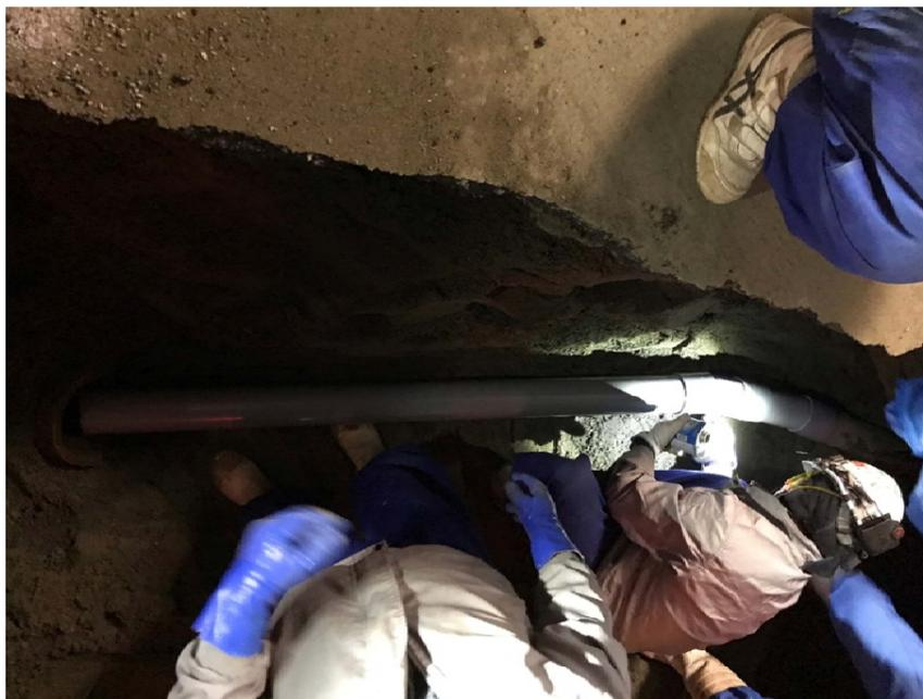
写真4 住宅下水管復旧状況
