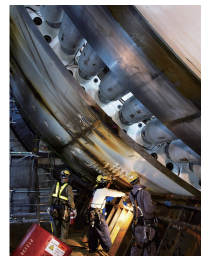
本線トンネル(南行) シールドマシンの中間部を組立てている状況
