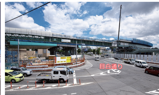
橋りょう架設(架設後の状況) 〔目白通り〕
