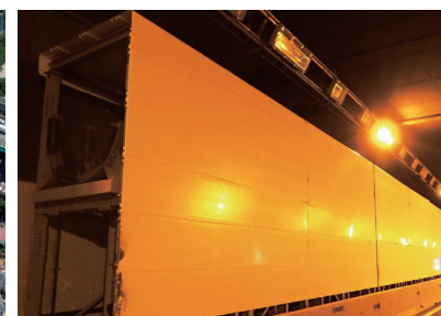
土砂運搬用のベルトコンベア設置状況
