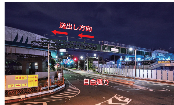
橋りょう架設(送出し作業中) 〔目白通り〕
