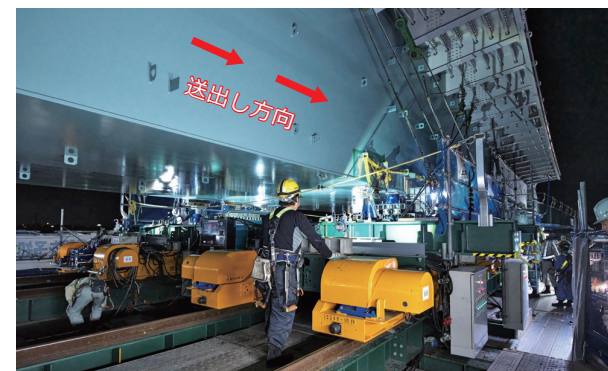
黄色の台車にて、台車上の橋げたを送出している状況
