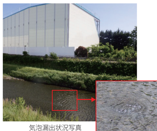
気泡漏出状況写真
