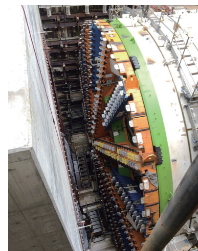
本線トンネル(北行) シールドマシン組立状況
