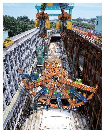
本線トンネル(北行) カッターヘッド投入
