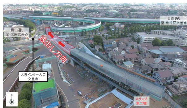
大泉 J C T 現場状況写真
