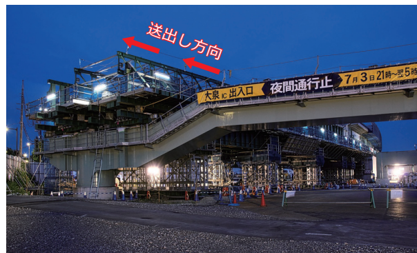
橋りょう架設(開始直前) 〔南側施工ヤード〕
