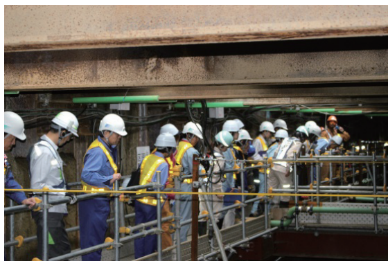
工事現場内通路の安全点検
