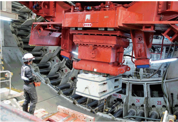
東名 JCT 北行シールド『がるん』の内部状況 (2018年1月)
