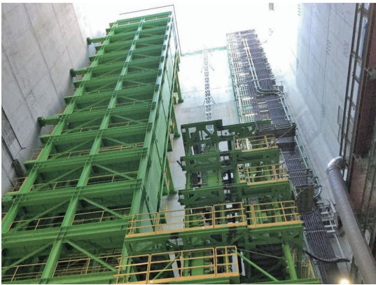
東名 JCT 南行立坑内のベルコン組立状況 (2018年1月)
