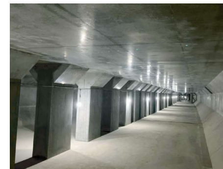
Hランプ工事の完了状況
