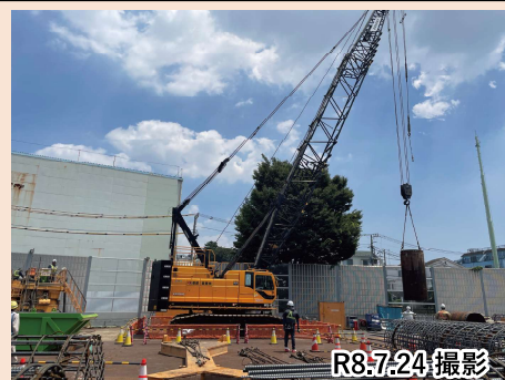
橋りょう下部工基礎施工状況
