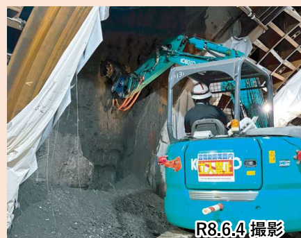
地中拡幅工事施工状況
