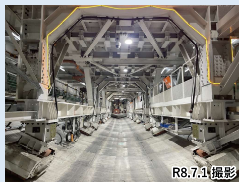
Fランプ工事の工事状況
