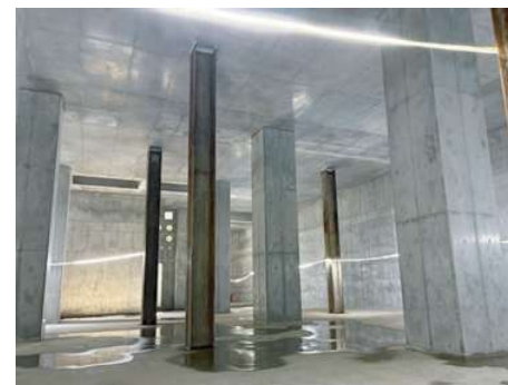
換気所地下工事の完了状況
