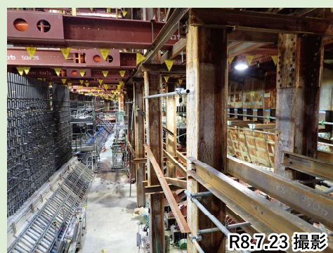
Bランプ開削区間の工事状況
