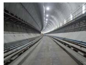
令和4年10月13日 中央JCT北側Hランプシールドトンネル掘進完了
