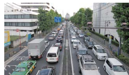
環状8号線 (杉並区高井戸東2丁目付近)
