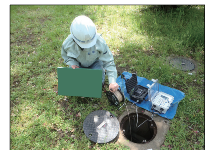
地下水位の観測状況
