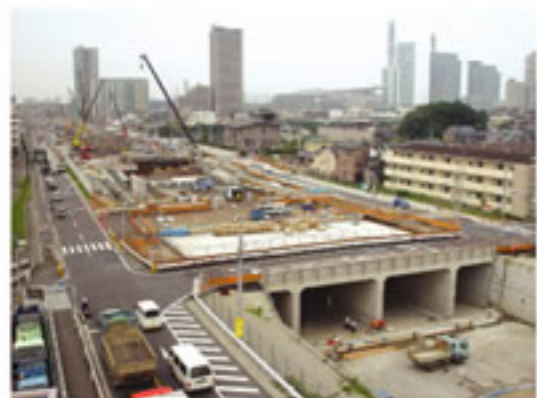
開削工事事例(首都高/埼玉新都心線)
