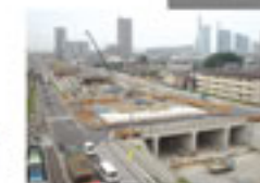
開削工事（首都圏/埼玉新都心線）
