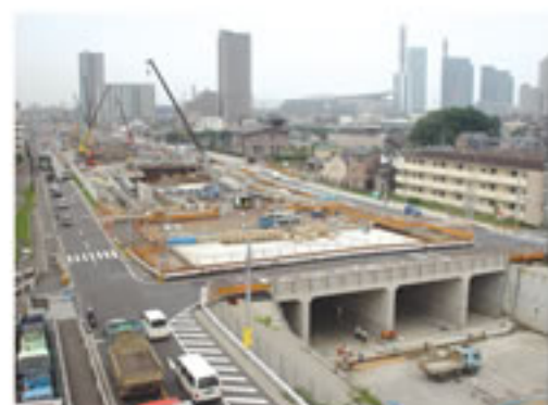
開削工事事例（首都高/埼玉新都心線）
