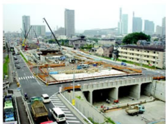
開削工事事例（首都高/埼玉新都心線）
