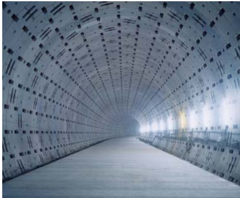
密閉型シールドトンネルの工事例
