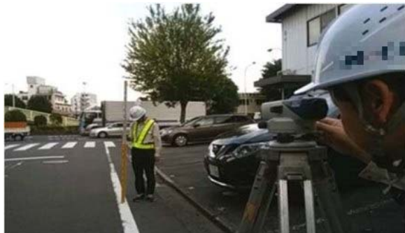
地上部での作業（イメージ）
