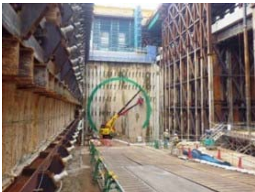
工事の写真（イメージ）
