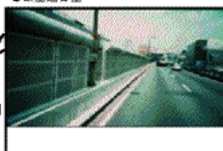
●吸音処理を実施したトンネル内部
