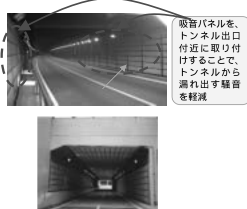
トンネル内の吸音処理
