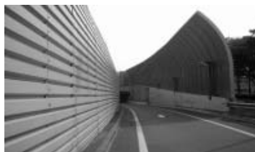
遮音壁（外環 和光地区）
