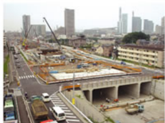
開削工事事例(首都高/埼玉新都心線)
