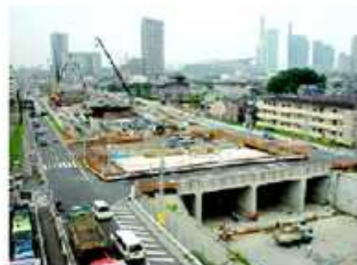
開削工事事例（首都高/埼玉新都心線）
