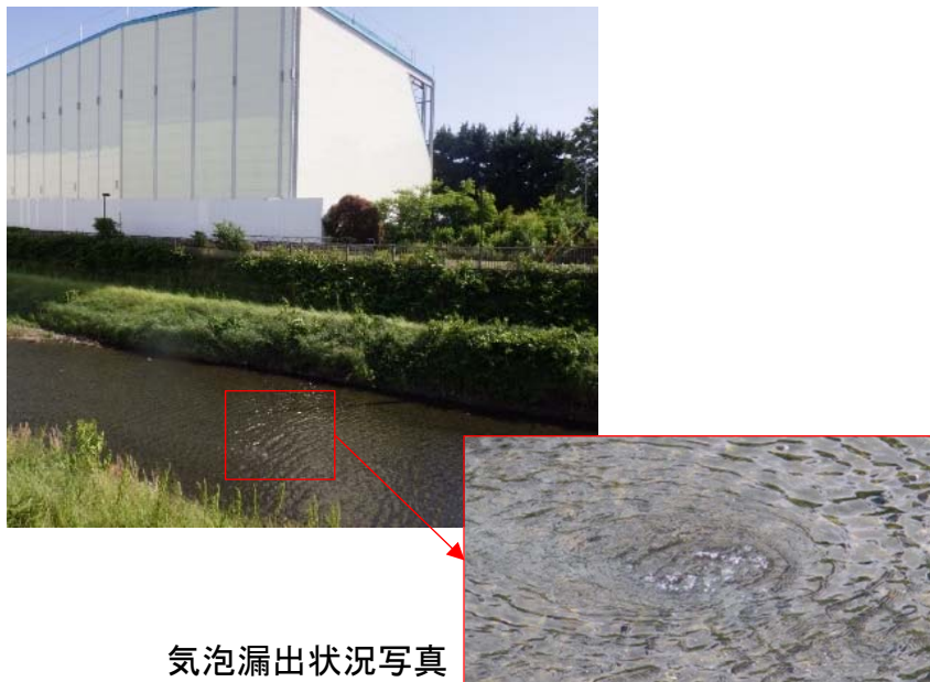
東名JCT周辺の野川の漏気状況
