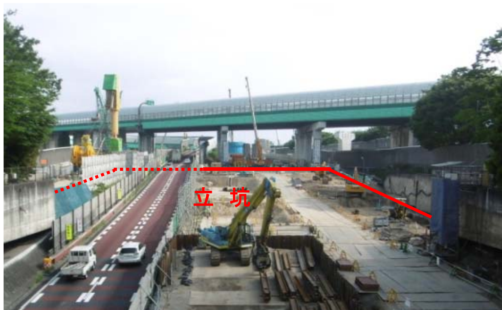
《大泉JCT立坑付近》
