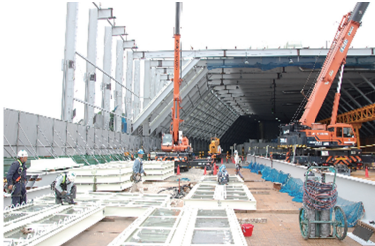
本線トンネル(北行) 土砂ピットヤードの状況
