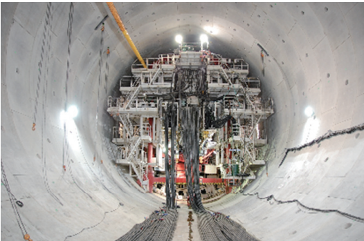
本線トンネル(北行) シールドマシン後方からの状況
