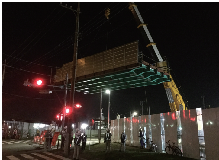
中央JCT工事用仮橋一括架設施工状況
