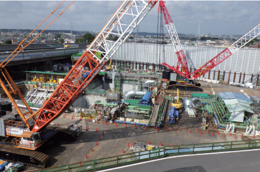
本線トンネル(南行) 立坑周辺の状況
