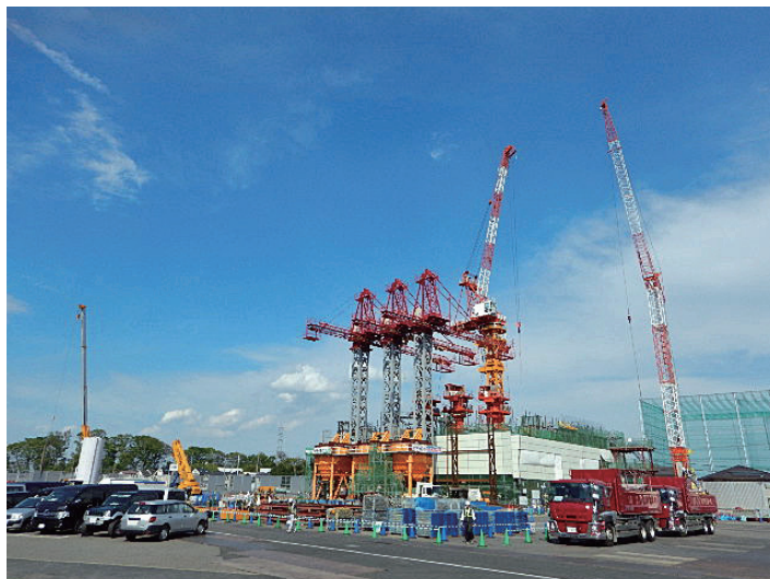
ケーソン現場状況
