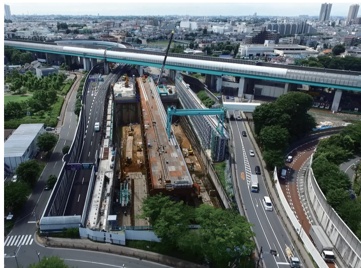
大泉工事現場状況
