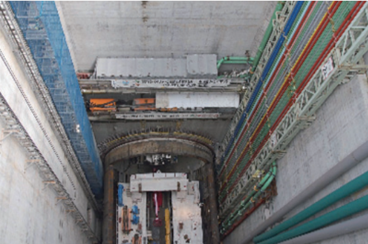
本線トンネル(北行) 立坑直下の状況
