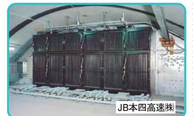
◆除じんの装置の例 (神戸淡路鳴門自動車道舞子トンネル電気集じん室(天井設置型))
