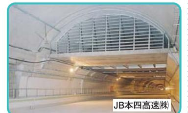
◆トンネル内の電気集じん室の例 (神戸淡路鳴門自動車道舞子トンネル電気集じん室(天井設置型))
