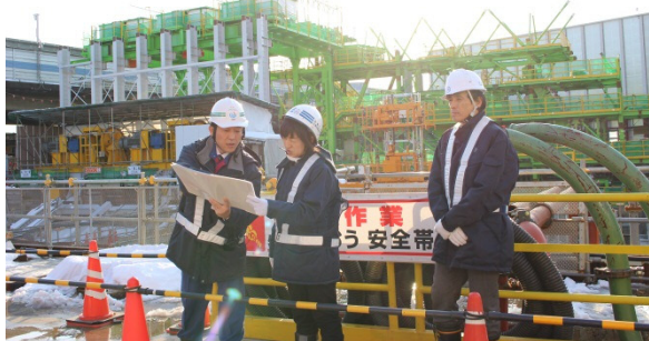
作業ヤードにおける視察
