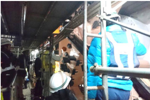
説明状況(立坑下)
