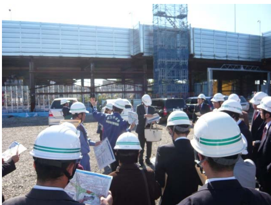
(仮称)中央JCT予定地
