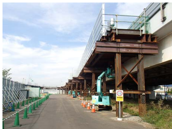
中央道へ出入りする工事用仮橋などを施工中 ※③
