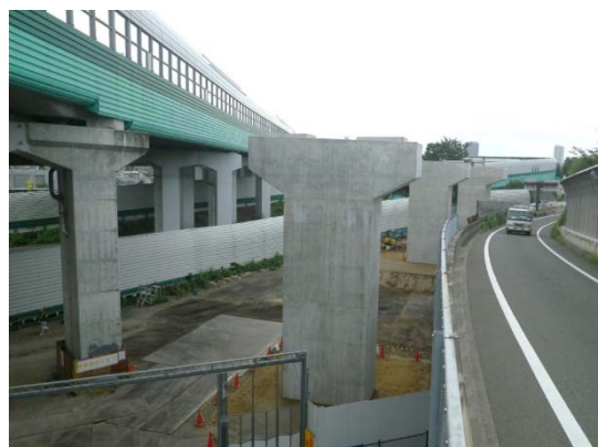
工事用車両が関越道へ出入りするための通路などを施工中 ※②
