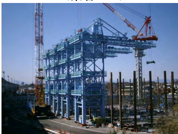
本線シールドを発進させるための立坑工事を施工中 ※①
