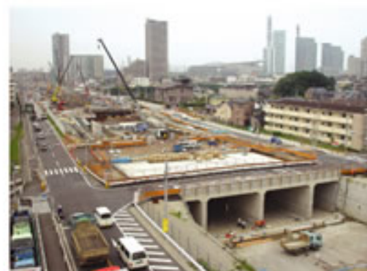
開削工事事例(首都高/埼玉新都心線)
