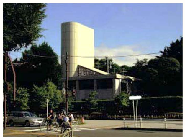
換気所の例 (国道20号新宿御苑トンネル新宿御苑換気所)
