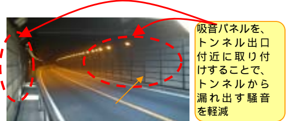
トンネル内の吸音処理
