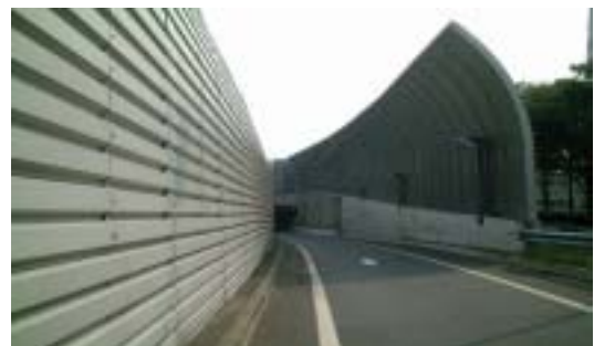
遮音壁（外環 和光地区）
