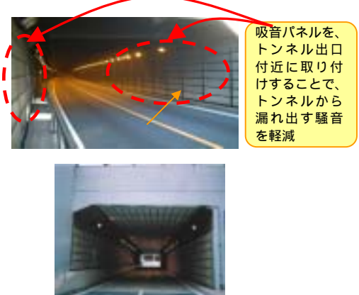
トンネル内の吸音処理
